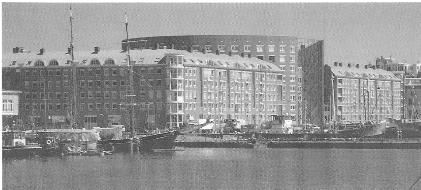
L'edificio progettato da Bruno Albert/Building projected by Bruno Albert
